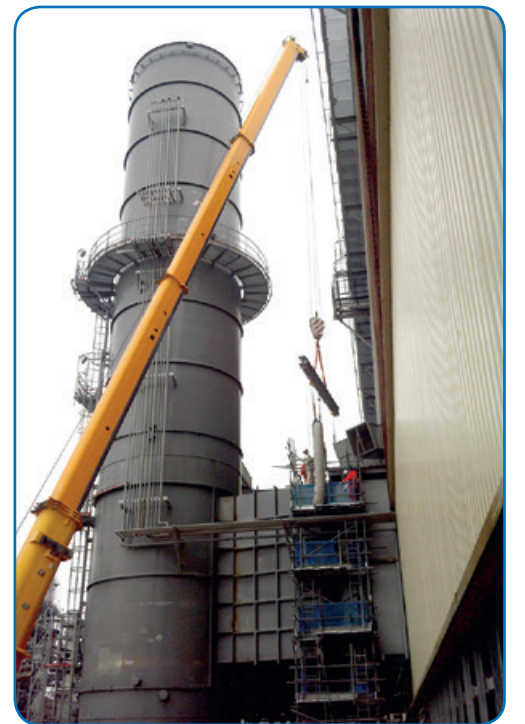
Установка компенсатора выхлопного канала газовой турбины
