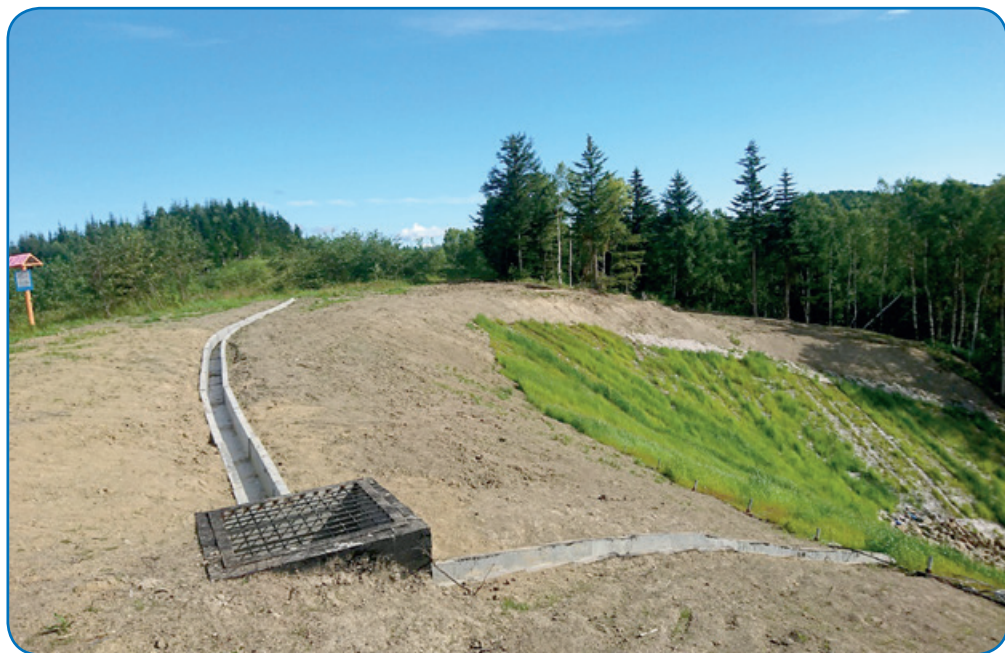
Укрепление оползневого склона с помощью анкерного поля
